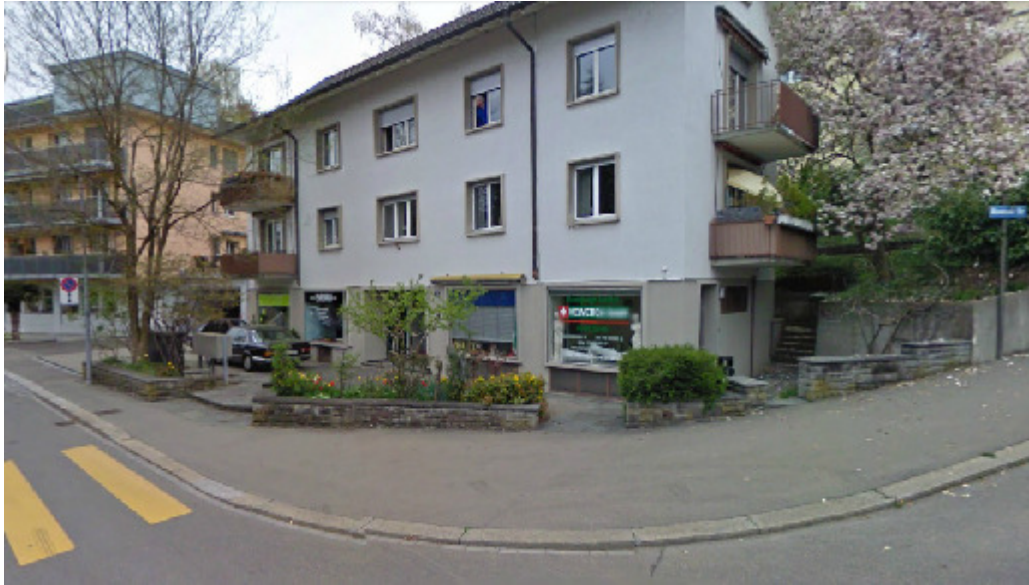
Hochstr. 73, 8044 Zürich (Systemsubstitution)
